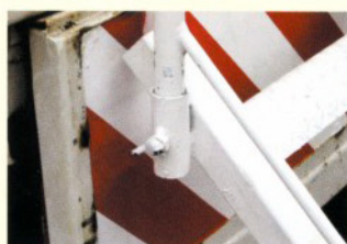
固定ボルト (昇降ステップ・安全柵)
