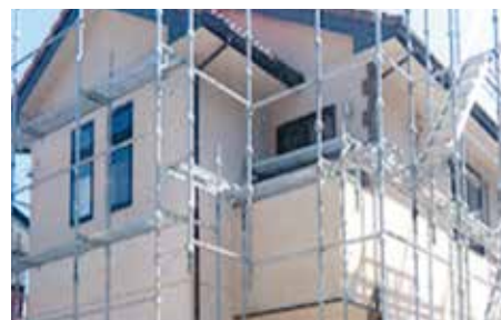
■低層住宅工事用 くさび緊結式足場
