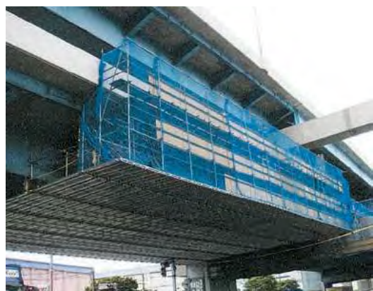
パネル式吊り棚足場工法
