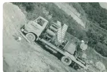
1966年 コンクリートポンプ車を導入
